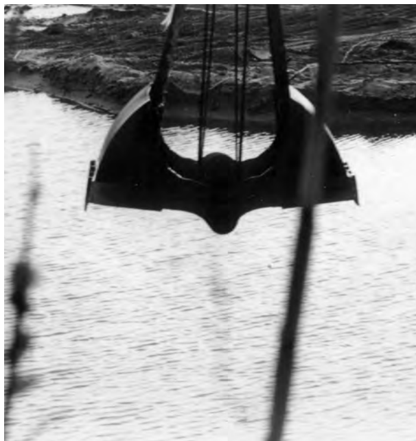
FIGURA 89. Culleres com aquesta, que es tancaven al fons i treien de cop un metre cúbic de sediment, van extreure gran part dels materials arqueològics.
